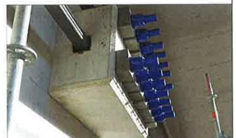
Lasteinleitung mit Hybridankern, Korrosionsschutzkappe von ANP Systems GmbH.
